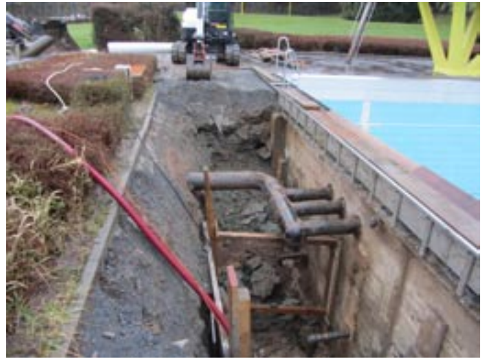
Zulaufrohre und Einströmdüsen wurden 2008 nicht mit erneuert und bereiten jetzt Probleme: Im Frühjahr 2015 musste schon die Wasserzufuhr im Sprungbecken repariert werden
