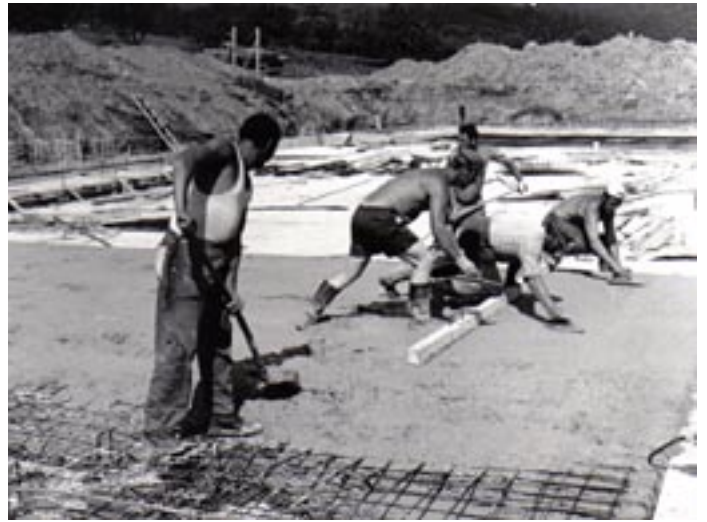
Das muss bis heute halten: Arbeiten am Hauptbecken des Fränkisch-Crumbacher Freibades im Jahre 1972
