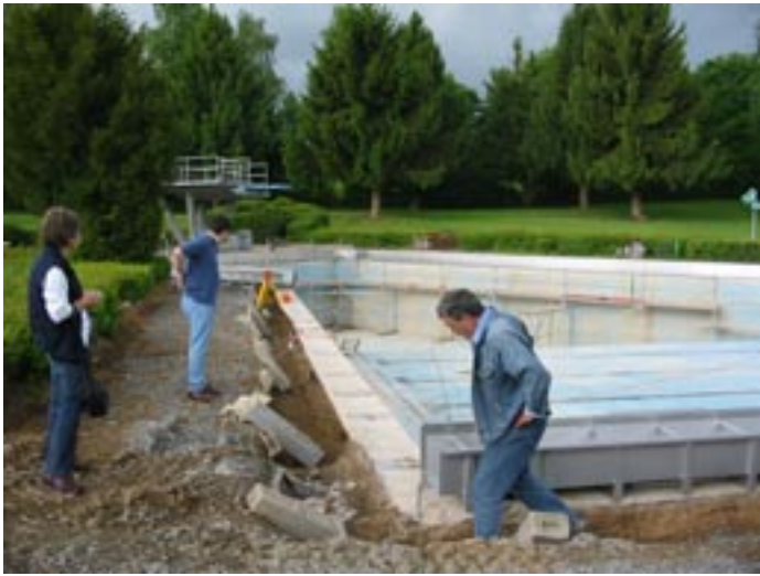
Altes Becken oben abgeschnitten, neue Überlaufrinne aus Edelstahl aufgesetzt: Die CDU-Fraktion begutachtet den Verlauf der Sanierungsarbeiten bei einem Ortsrundgang 2008
